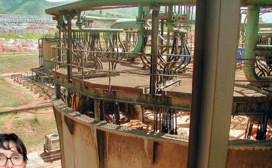
Réacteur de biolixiviation pour la récupération du cobalt à partir de pyrites cobaltifères (Projet KCC, Ouganda). © BRGM - Dominique Morin
