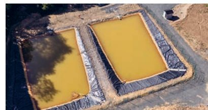
Vue aérienne des deux bassins décanteurs de la station de Lopérec. © BRGM
